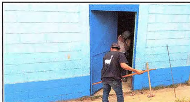
Foto 3: Se observa los trabajos con la rectificación de las puertas del modulo 1
