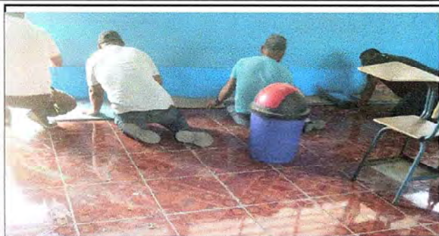
Foto1: Se observa la aplicación de la pintura en las paredes con trabajos de padres de familia en el modulo 1.
