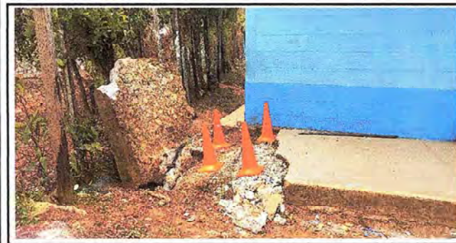
Foto 5: Se observa la reparación de la hundición que padece el corredor en el modulo 1.
