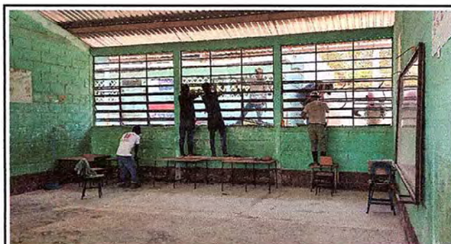
Foto 4: Se observa la limpieza de las bases de los vidrios e reemplazando las partes inservibles en el modulo 1
