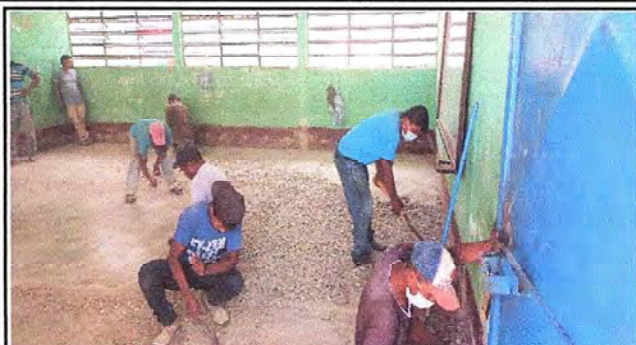
Foto 2: Se observa la preparación del espacio donde será instalado el piso cerámico con la ayuda de los padres en el modulo 1
