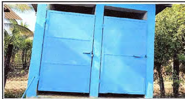
Foto 6: Se observa la reacondicionamiento y mantenimiento de la batería de letrina para niñas.
